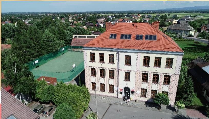
Budynek szkoły - stan obecny
