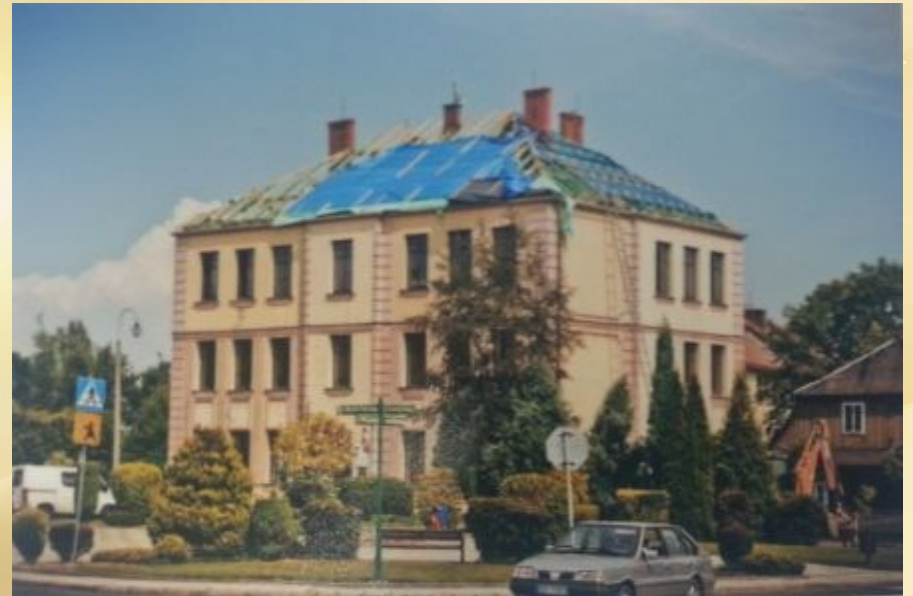
Inwestycja związana z modernizacją całego budynku w latach 2013-2014
