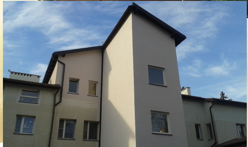
Rozbudowa i przebudowa istniejącego budynku na potrzeby przedszkola w Dankowicach
